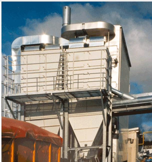
Dans la fabrication de crayons d'écriture et de cosmétiques la « coque » en bois est faite sur des machines de fraisage. Les copeaux de bois qui en résultent sont aspirés à la machine et déposés dans un **collecteur central de poussière de type INFA-JET**. Le filtre se trouve en aval d'un équipement de fabrication de briquettes, dans lequel les copeaux sont comprimés.
