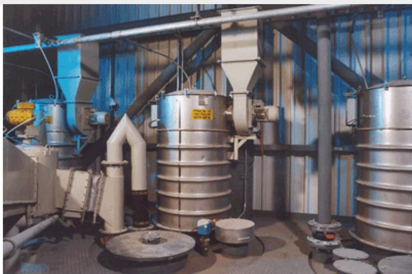
Pour le mélange dans une usine de ciment plusieurs silos pour le ciment, le calcaire, les cendres volantes et le GGBS ont été installés. Ces silos sont remplis par ascenseur à godet avec les produits.
